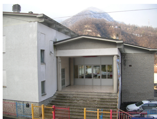
Vista da via Cadamiani
